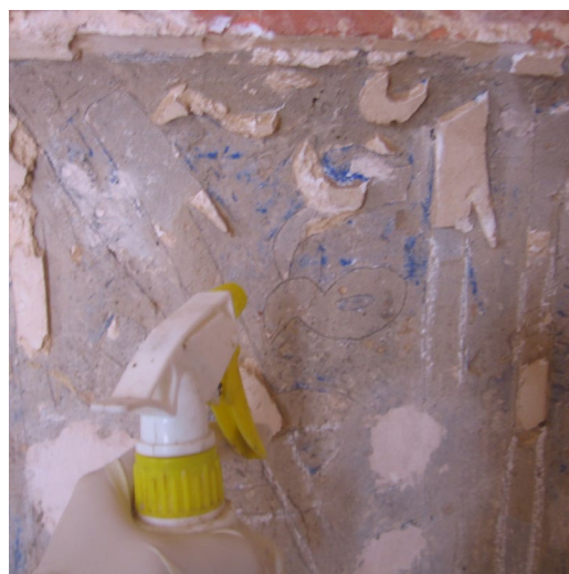
شکل ۳۹. استحکام بخشی تمام سطح کتیبه گچبری با محلول پارالوئید B72 سه درصد در استون به روش اسپری کردن (عکس از نگارنده)
