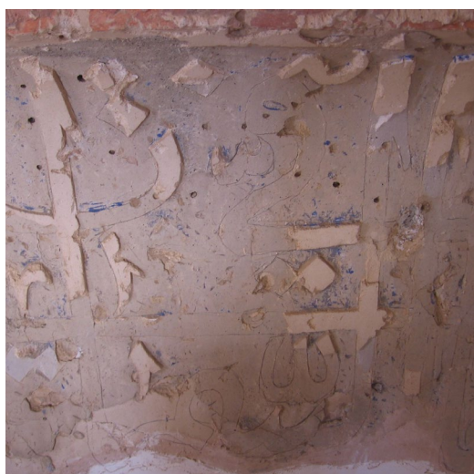
شکل ۳۱. راست: سوراخ های بزرگ ایجاد شده در سطح کتیبه گچبری در اثر فعالیت موربانه؛ چپ: سوراخ های کوچک ایجاد شده در سطح کتیبه گچبری توسط موربانه (عکس از نگارنده)
