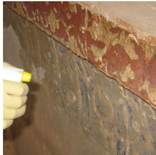
شکل ۳۳. تثبیت اولیه لایه‌های سست رنگ و گچبری با اسپری پریمال ۳ درصد (عکس از نگارنده)
